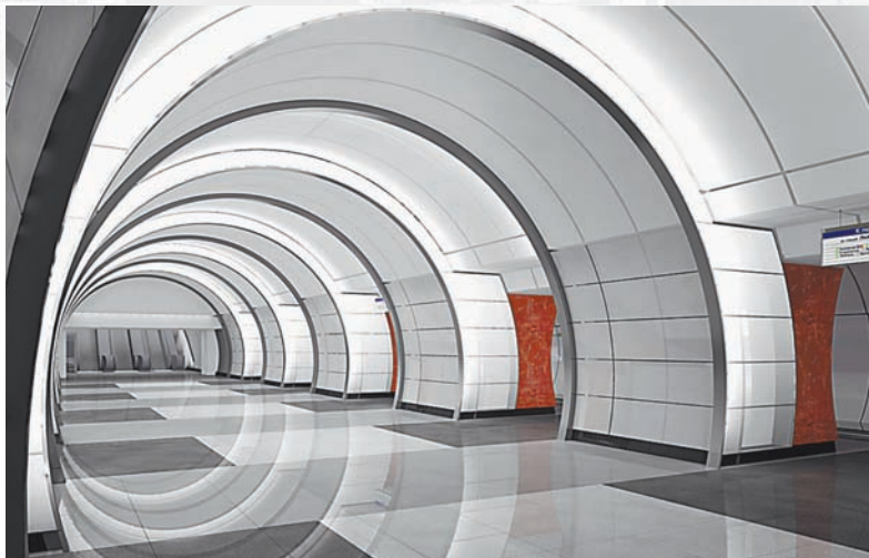
Такой будет после открытия станция «Фонвизинская».
