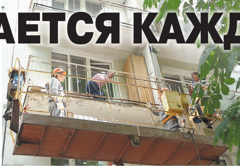
Создана система финансирования капремонта - и с 2014 г. работы начались. Фото Валерия ХРИСТОФОРОВА
