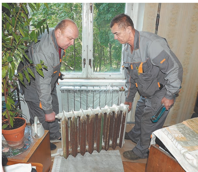
Всего 2,5 часа - и батареи в однокомнатной квартире уже новые. Фото Валерия ХРИСТОФОРОВА
