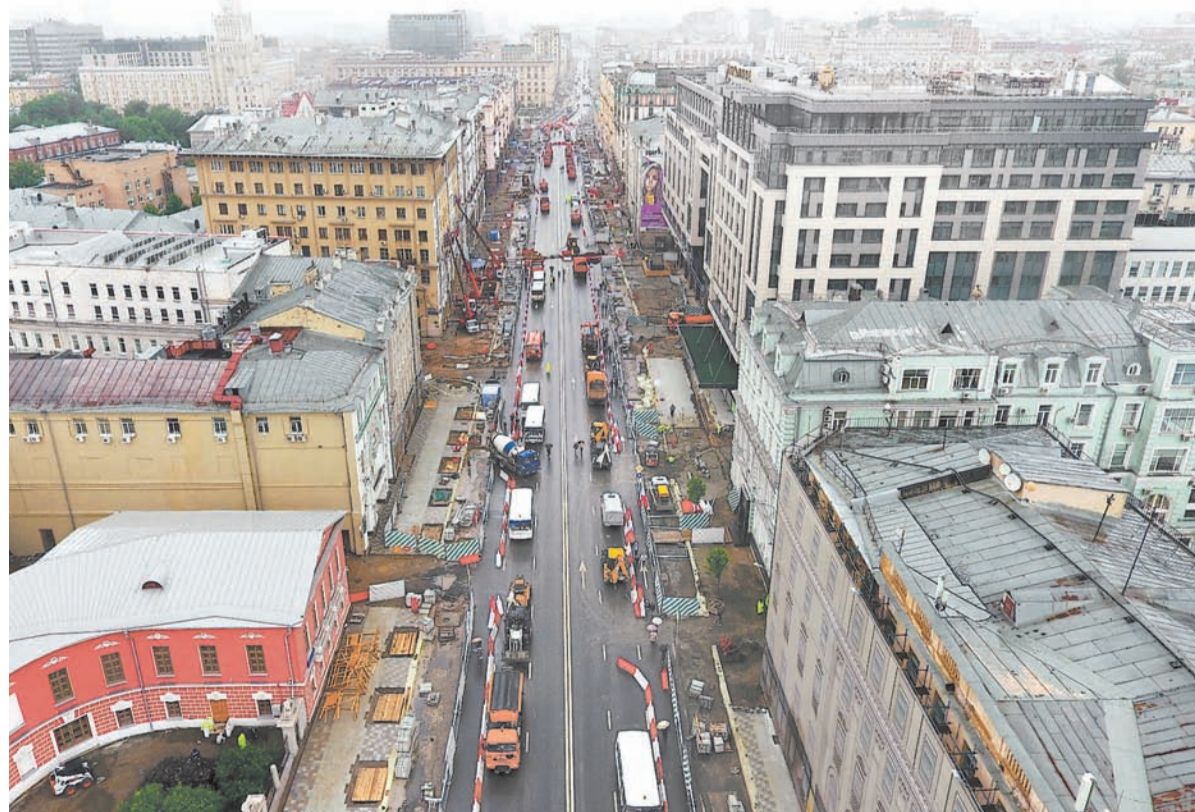
Сейчас между Манежной и Триумфальной площадями зарыли траншею и положили временное покрытие. Когда будут класть постоянное, перекрывать движение на Тверской не потребуется.
