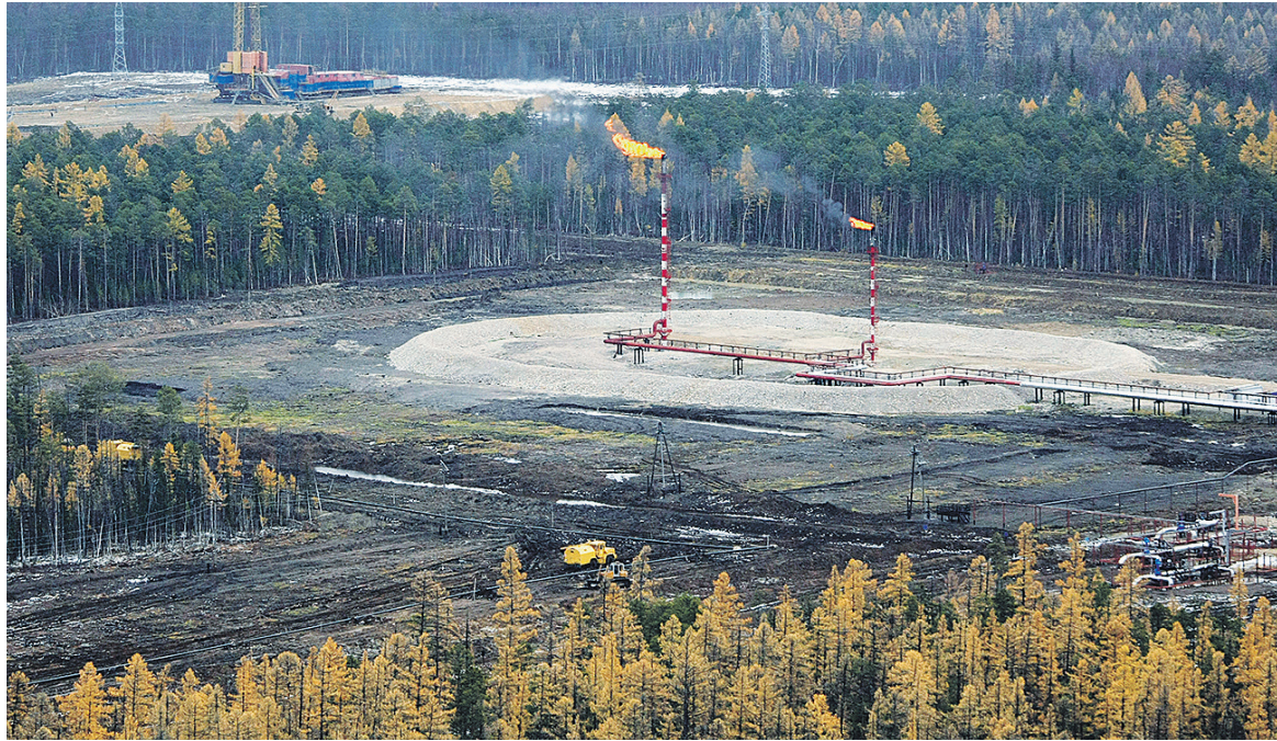
Мимо Борулахского участка проходит нефтепровод «Восточная Сибирь — Тихий океан», по которому нефть направляется в Китай и другие азиатские страны
