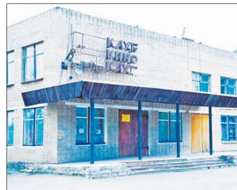
В поселке Сидоровка о клубе осталась лишь память. Несколько лет назад здание было разрушено до основания.
