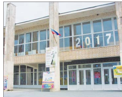
В ГДК срочно необходимо отремонтировать крышу.
