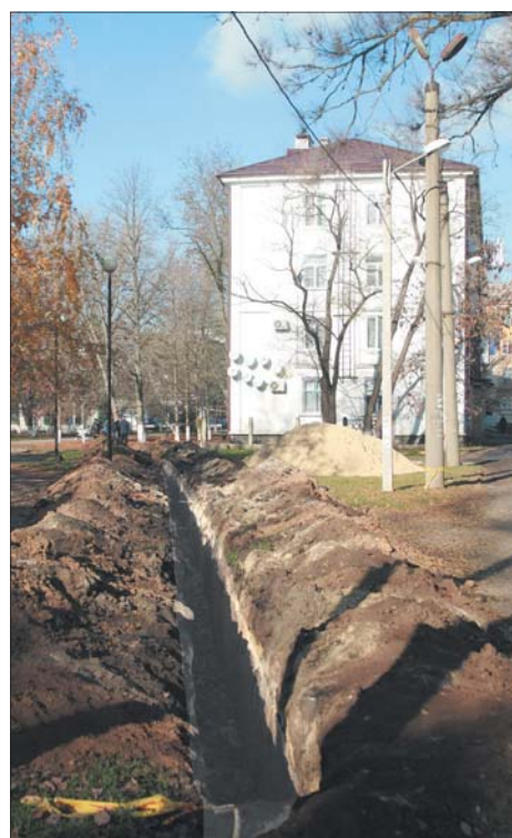
Около дома № 10 уже готова траншея под газификацию.
