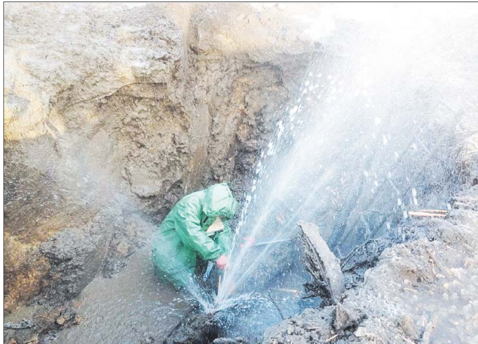
В Шахтах часто случаются порывы водопровода, которые чинят вбиванием чопиков
