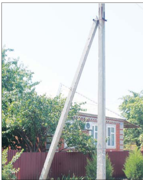
Столбы для монтажа ЛЭП уже установлены.
