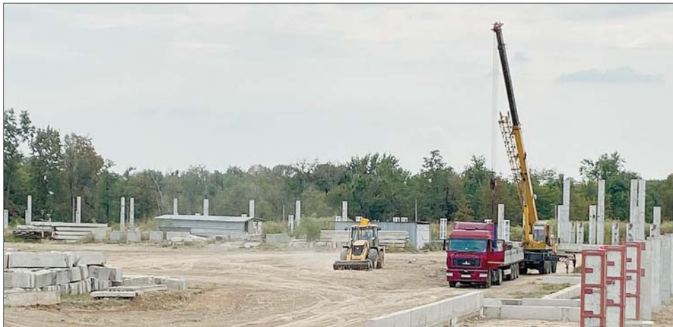
К строительным работам на стадионе «Шахтёр» приступил новый подрядчик.
