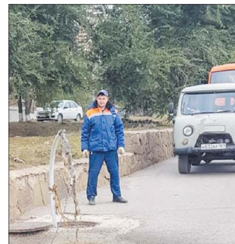
Аварийные бригады водоканала работают ежедневно и круглосуточно, даже на нерабочей неделе.
