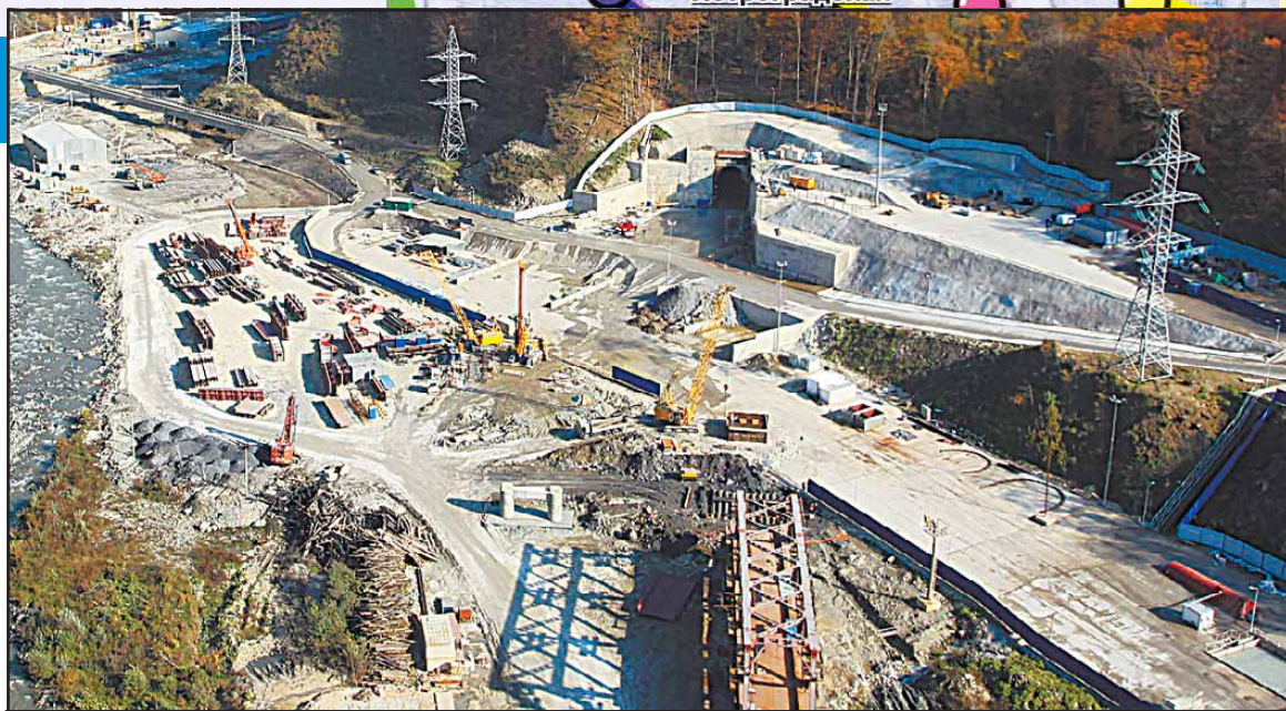
Тоннели, возведенные по проектам нашего института в Сочи, получили высокую оценку.
