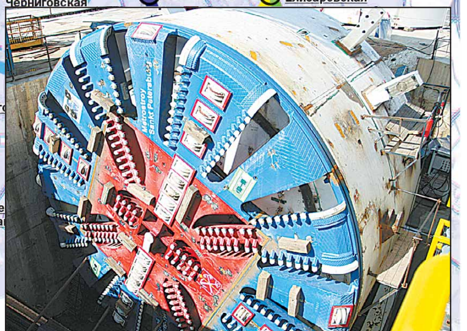
Современные технологии, применяемые строителями и проектировщиками, позволяют строить объекты метрополитена качественнее, надежнее и быстрее.
