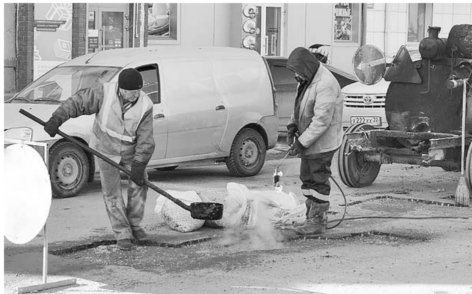
Сейчас при ремонте дорожники используют холодный асфальт, который отличается высокой прочностью.
