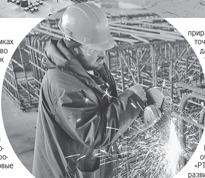
Монтаж оборудования на высокотехнологичном предприятии - дело тонкое.
