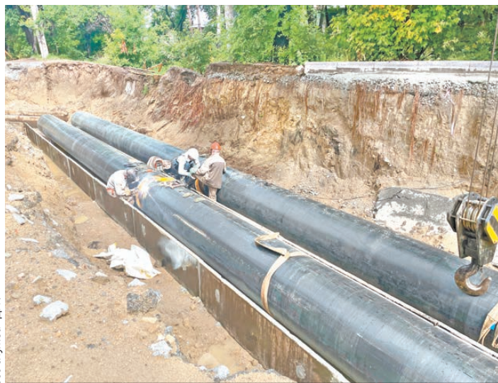
Сроки монтажа предизолированной трубы меньше, чем классической.
