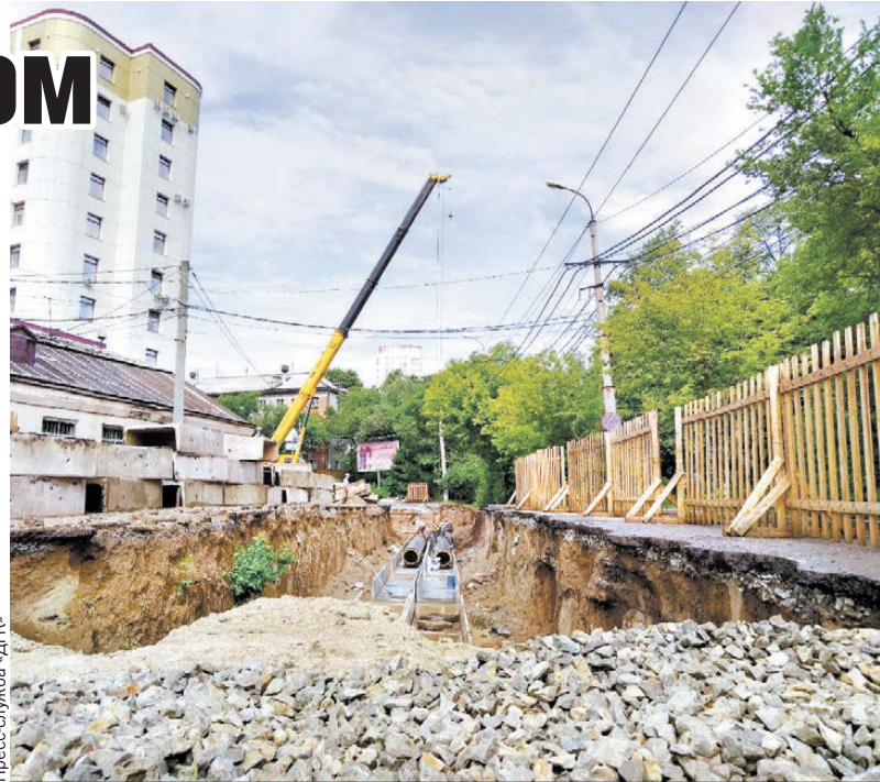
Работы на улице Синельникова.
