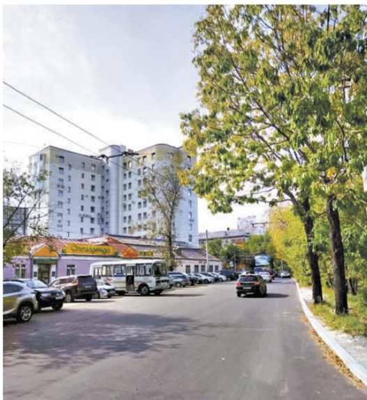
Еще месяц назад на Синельникова кипели работы, сейчас здесь уложен свежий асфальт.
