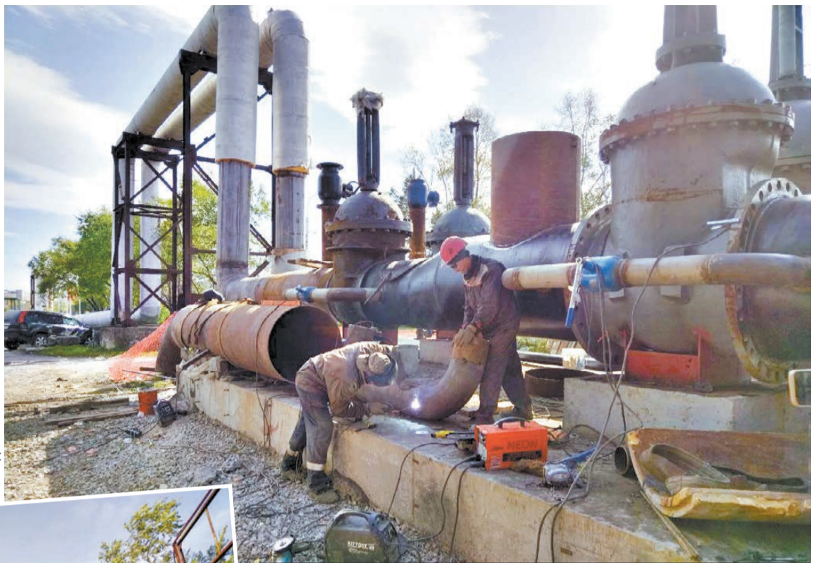
На участке ТМ-31 на Промышленной сетевике завершают последние сварочные работы.
