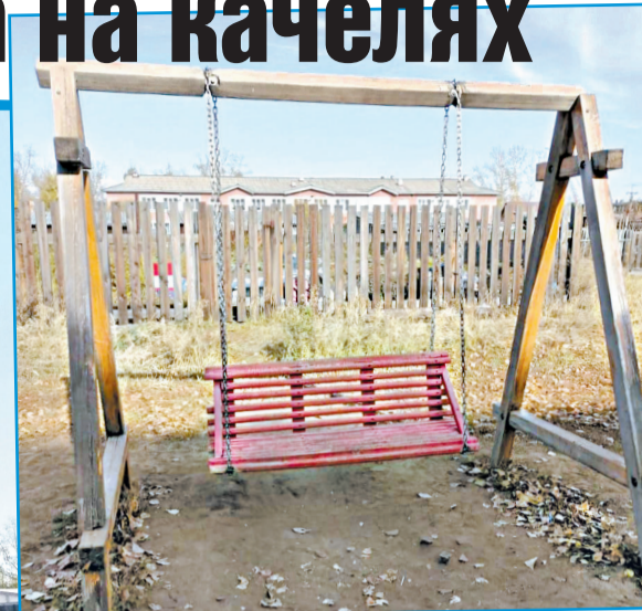
Верхняя планка была закреплена на саморезы, их вырвало с корнем и конструкция обрушилась на школьника.
