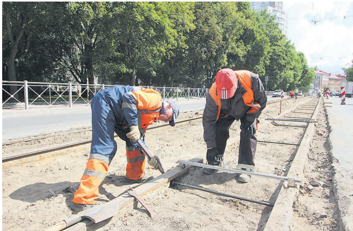
Рабочие на улице Багратиона старательно закручивают новые шпильки, которые не дадут рельсам разболтаться.
