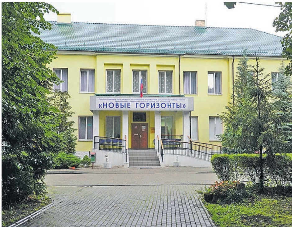
Центр «Новые горизонты» готовится к строительству еще одного корпуса.
