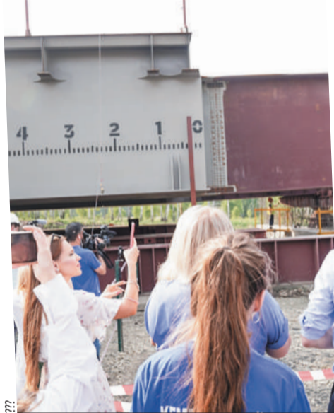
Чтобы видеть, как движется пролет моста, строители используют специальную измерительную шкалу.
