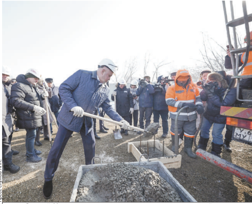
Сергей Цивилев принял участие в заливке первой сваи будущего восьмиэтажного лечебного корпуса на 320 коек.
