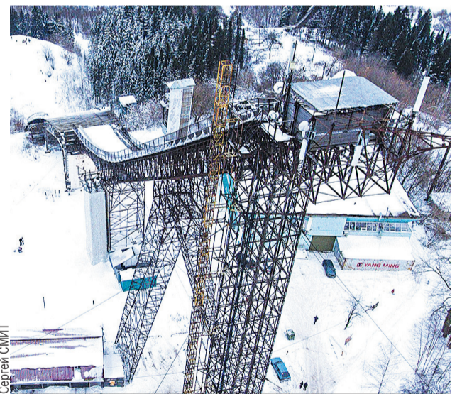
90-метровая конструкция не используется уже несколько лет.
