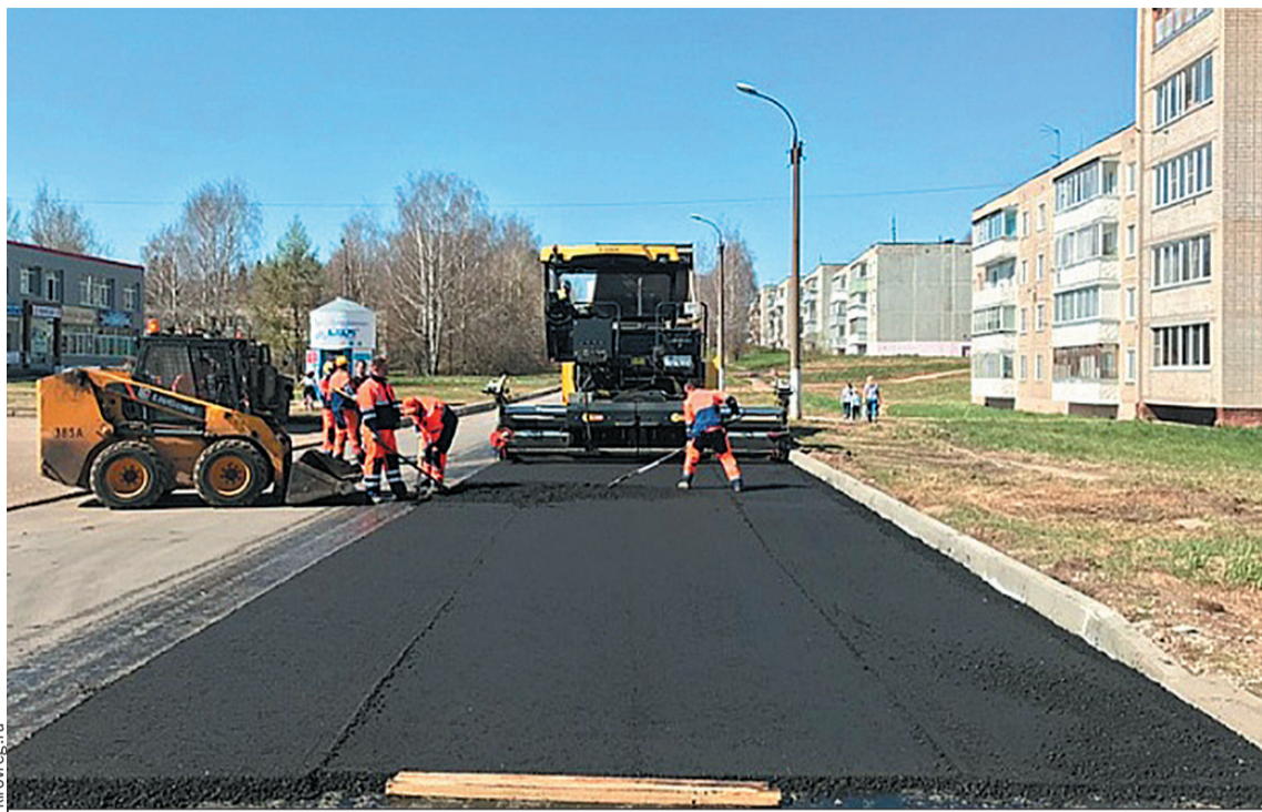
Работы на улице Сурикова будут вестись на отрезке от Некрасова до Комсомольской.
