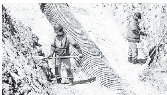
Компания обеспечит микрорайон дорожной и инженерной инфраструктурой.
