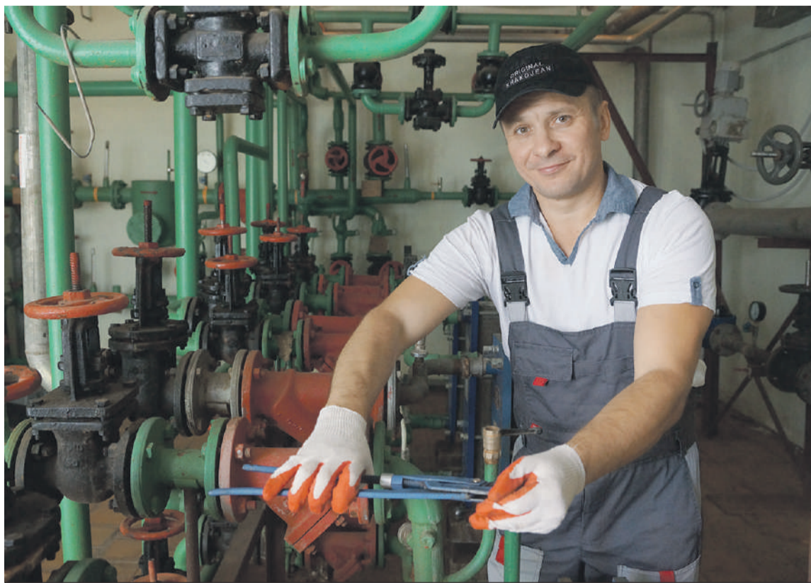
Все работы должны завершиться к 1 сентября.
