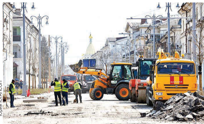
Главные хозяева улицы - строители.
