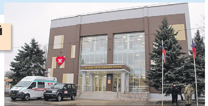
Строительство нового перинатального центра в Донецке.
