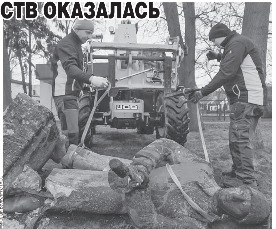
У поляков нет ничего святого - на фото демонтируют памятник красноармейцу, который установили сразу после войны.
