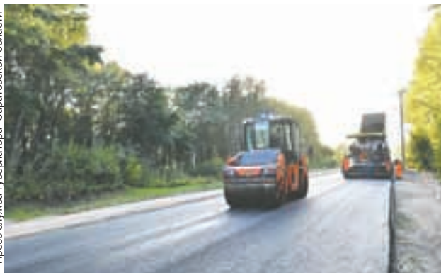
Ремонт дорог в рамках национального проекта идет по всей области.
