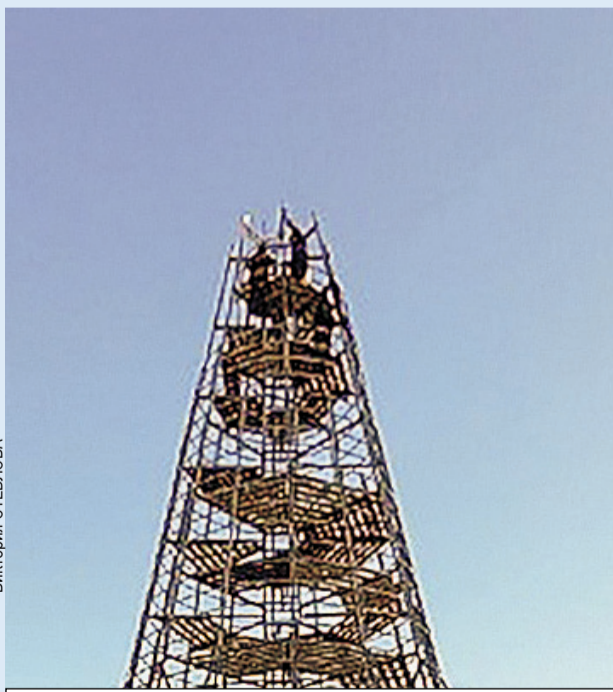
Монтажники практически возвели каркас зеленой красоти.
