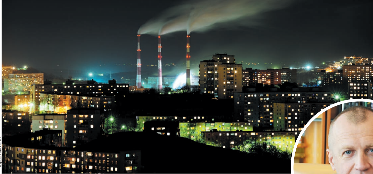
Владивостокская ТЭЦ-2 обеспечивает электричеством весь краевой центр и 60% жителей теплом.
