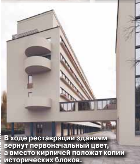
Дом Наркомфина когда-то выкрасили в желтый, а кирпичами заделывали обвалившуюся стену.
