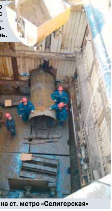
Работы на ст. метро «Селигерская»
