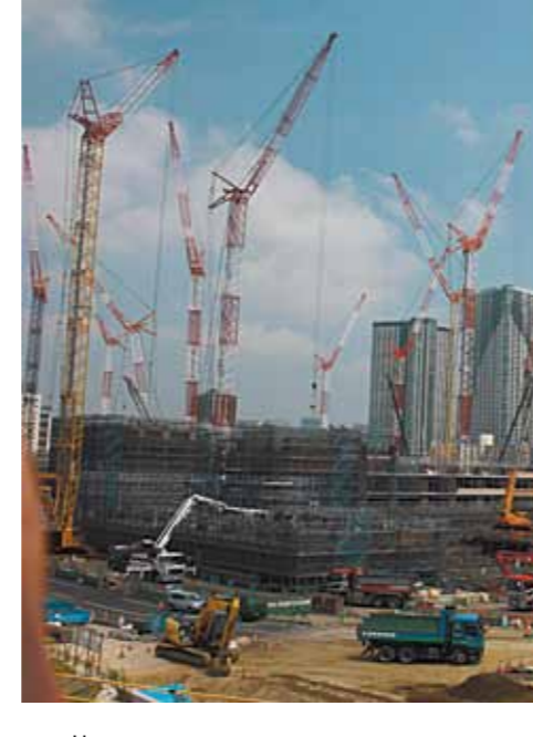
Здесь будет построена олимпийская деревня.
