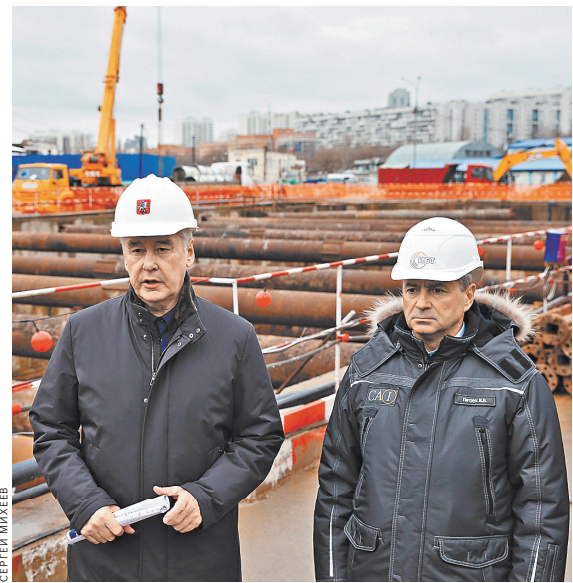
Мэр Москвы Сергей Собянин назвал очень важным строящийся южный участок Большой кольцевой линии метро.
