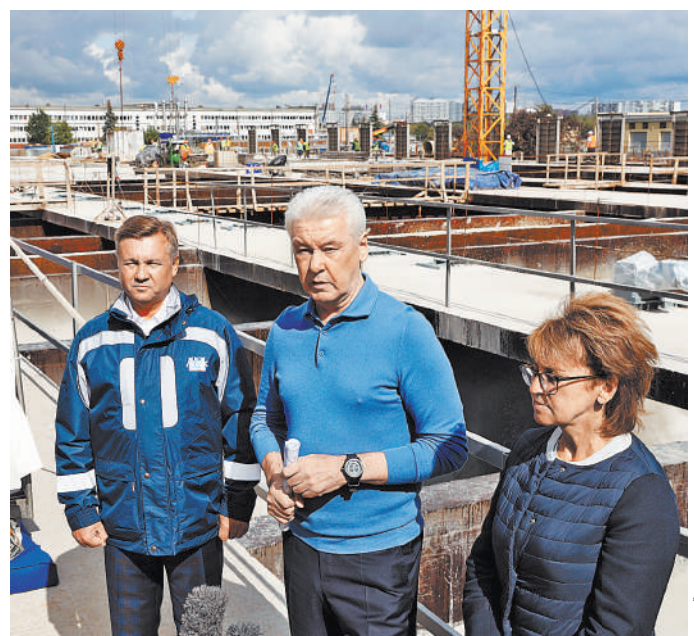
Сергей Собянин: Очистные сооружения, прослужившие более полувека, постепенно превращаются в современные.
