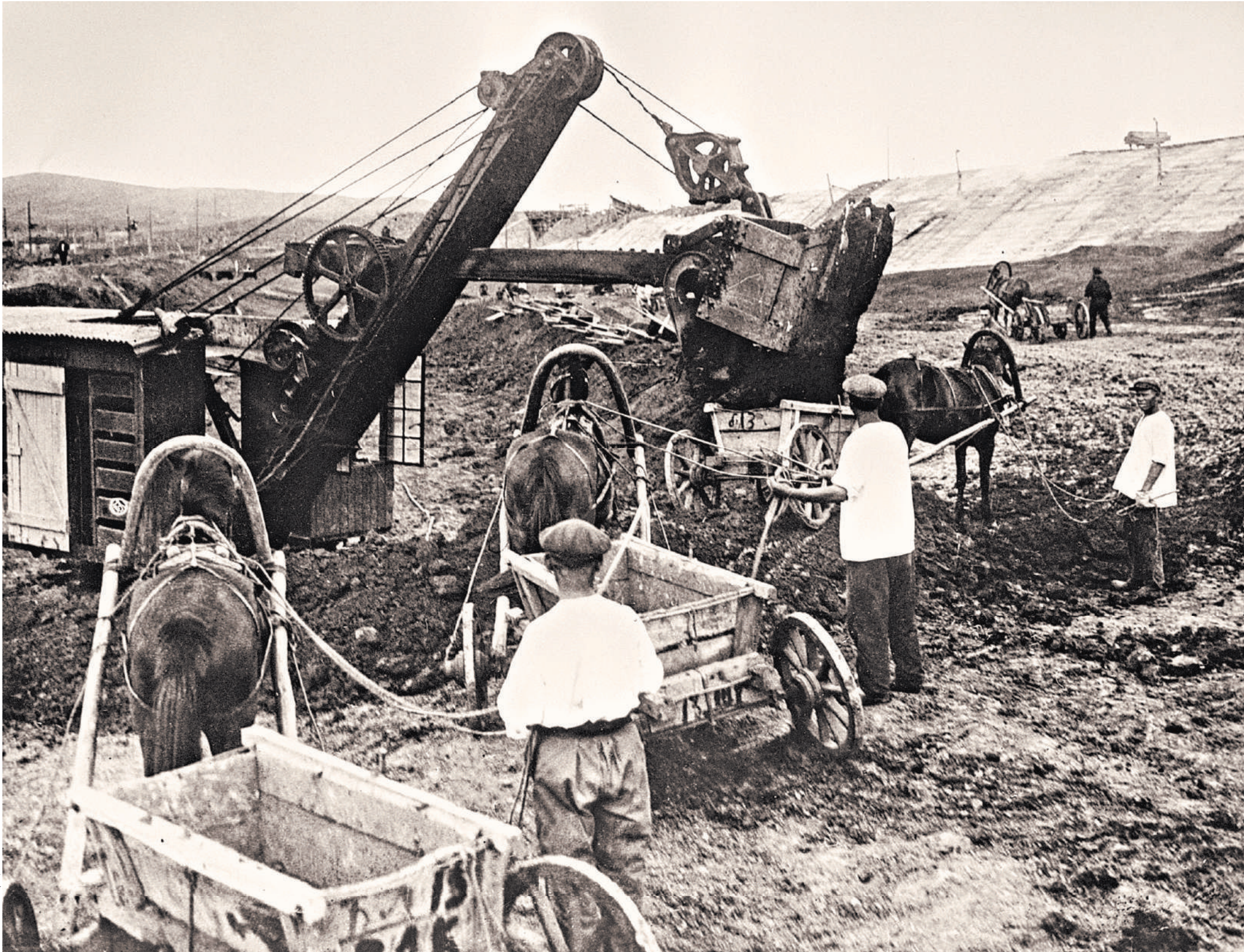
Погрузка грунта экскаватором во время строительства Магнитогорского металлургического комбината. 1 июня 1929 года.
