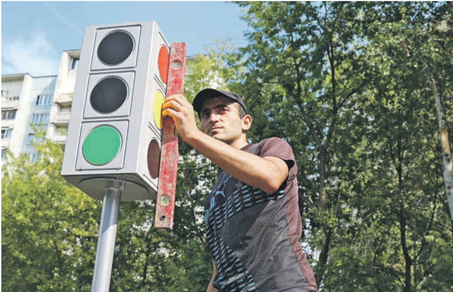
13 августа 13:34 Светофор — не береза, поэтому должен стоять «по стойке смирно». Рабочий Гарик Вардунян несколько раз проверяет, не склонился ли учебный экспонат набок. Обращает внимание на, казалось бы, пустяковые миллиметры. И только после этого прикручивает светофор на века
