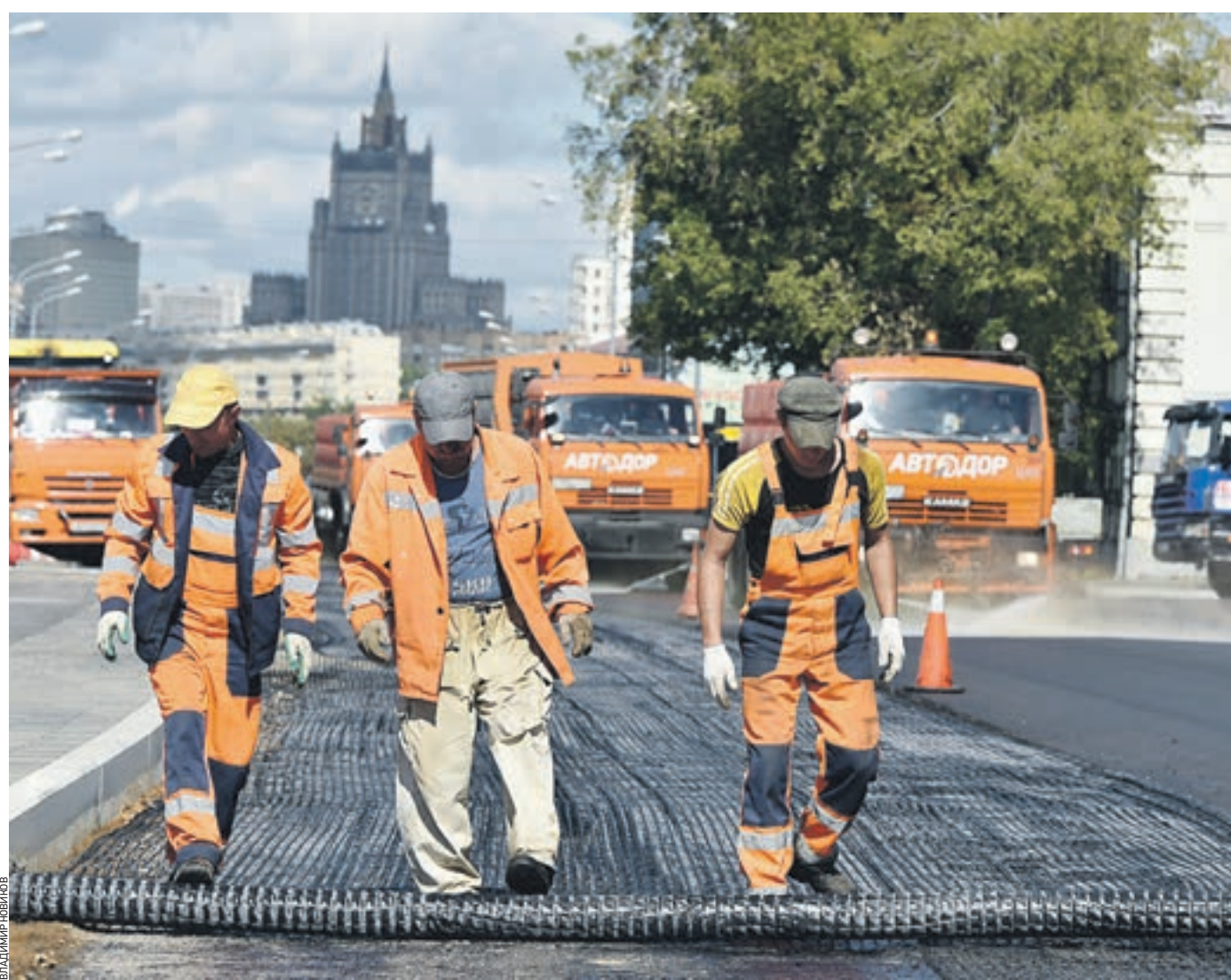
14 августа 14:48 Дорожные рабочие укладывают сетчатую основу для асфальта на Новодевичьей набережной
