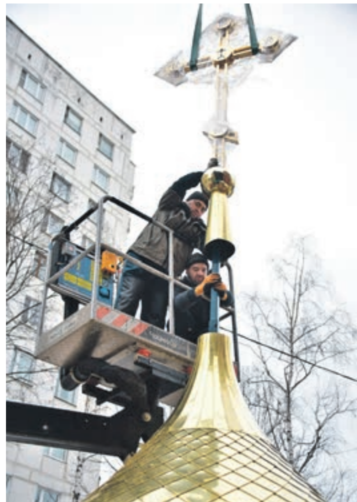
Вчера 15:17 Сварщик Андрей Кошкин (слева) и кровельщик Михаил Павлов устанавливают на новом куполе храма крест
