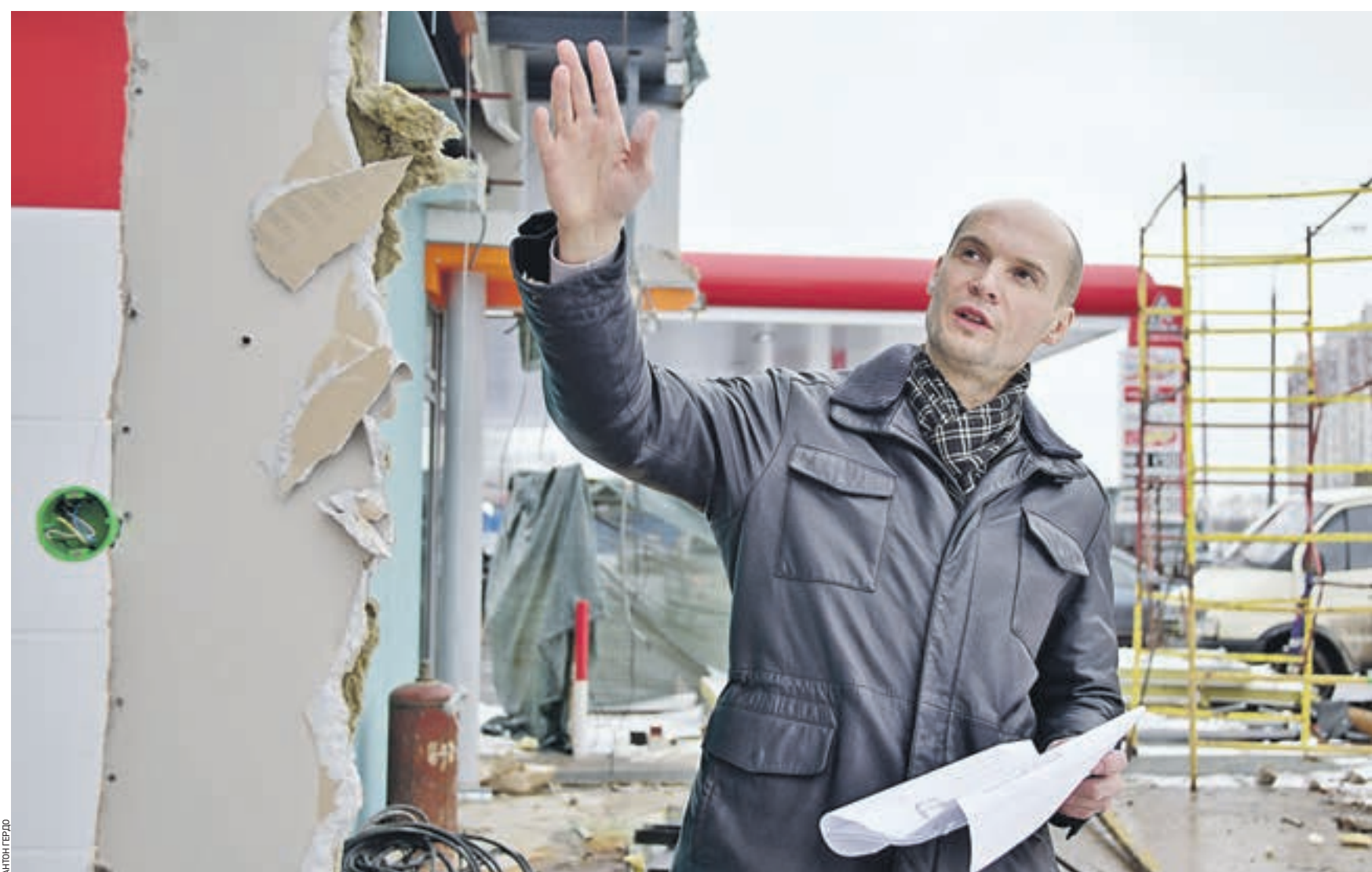
Вчера 11:40 Директор компании — владельца здания, признанного городскими властями самостроем, Александр Ерастов показывает, как проходит демонтаж. От размещавшегося в здании кафе остался лишь фундамент — предстоит только перенести оборудование и разобрать помещение, где располагается магазин
