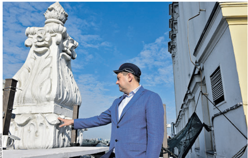
4 сентября 10:39 Глава Департамента культурного наследия Москвы Алексей Емельянов осматривает одну из 12 башен гостиницы «Пекин», где сейчас идут реставрационные работы
