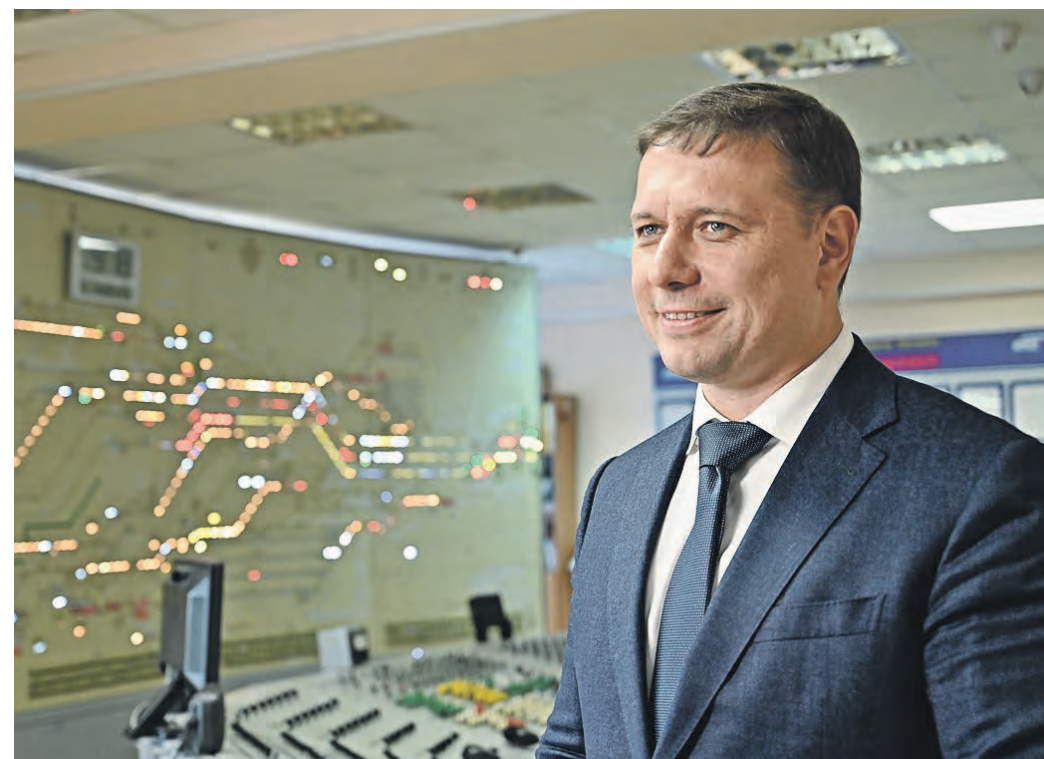
Вчера 09:55 Начальник станции Москва-Пассажирская-Ярославская Антон Крючков рассказывает о работе поста электрической централизации
