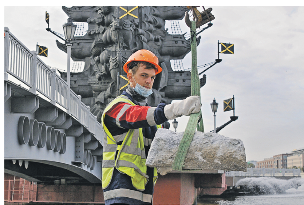
Вчера 11:57 Специалист участка № 7 ГБУ «Горьmost» Евгений Кривошеев с помощью мини-крана возвращает очищенный гранитный камень на прежнее место
