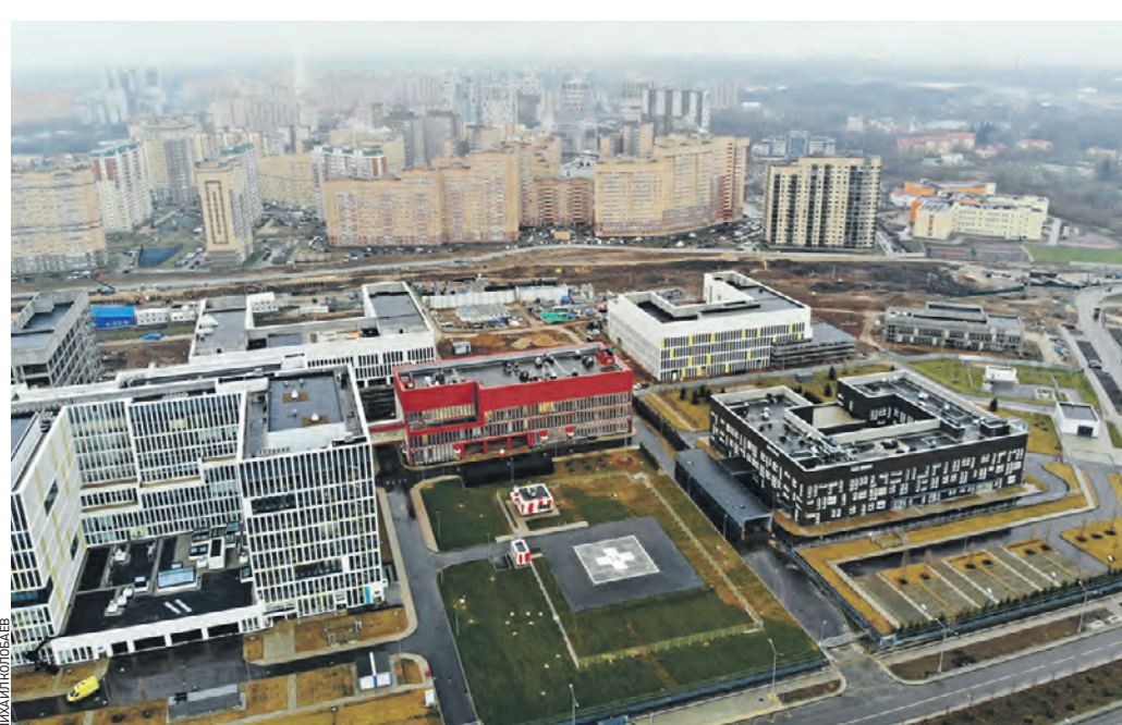
27 декабря 2019 года 11:30 Вот так выглядит больничный комплекс в поселке Коммунарка с высоты птичьего полета
