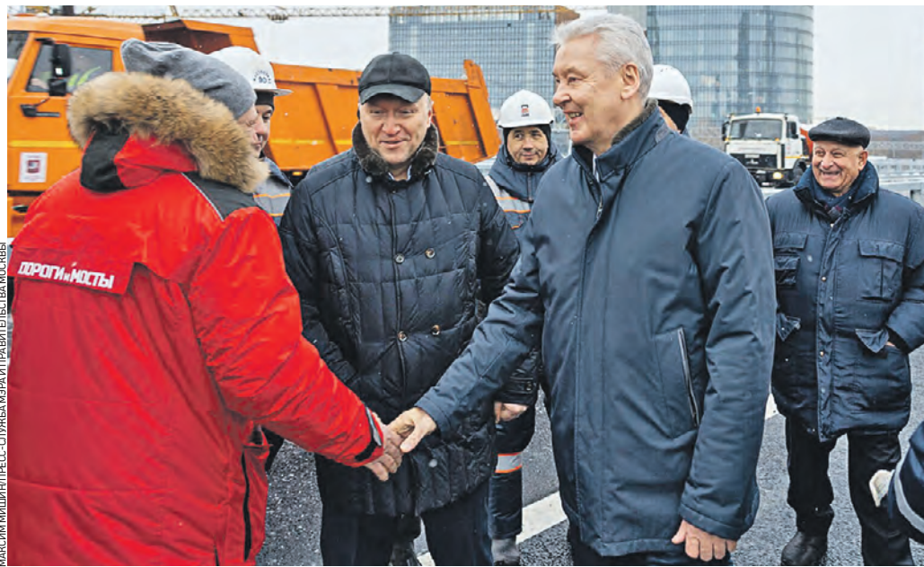
Вчера 11:15 Мэр Москвы Сергей Собянин (справа на первом плане) благодарит представителя генпродрайчика Владимира Котылевского (слева) за работу на участке хорды. На втором плане: заммэра Москвы по вопросам градостроительной политики и строительства Андрей Бочкарев (слева) и первый замруководителя Департамента строительства столицы Петр Аксенов (справа)
