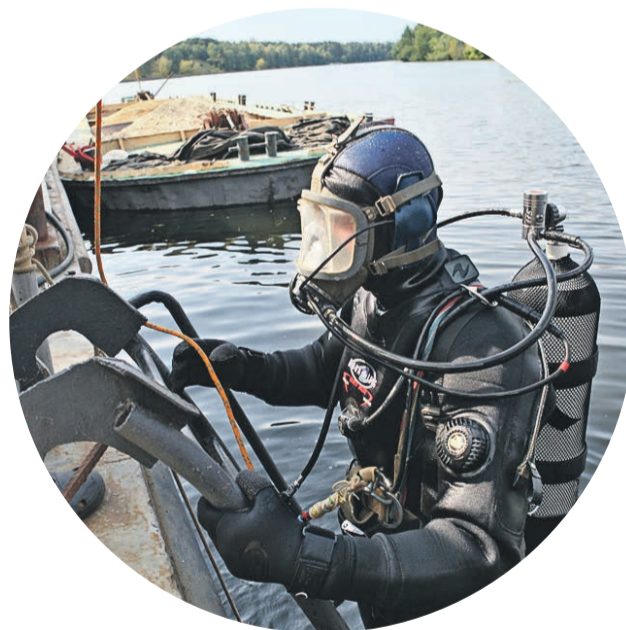
26 августа 2015 года. Водолаз Олег Власов исследует подводный газопровод, который пролегает по дну Москвы-реки
