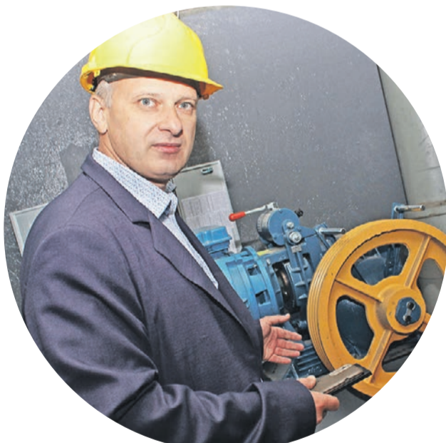
31 августа 2015 года. Заместитель гендиректора компании-подрядчика Сергей Грачев проверяет новое лифтовое оборудование
