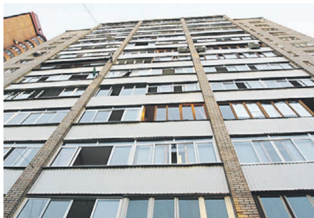
Этот дом № 48, корпус 2, расположен на 15-й Парковой улице в районе Северное Измайлово. Каждый месяц его затопливает нечистотами
