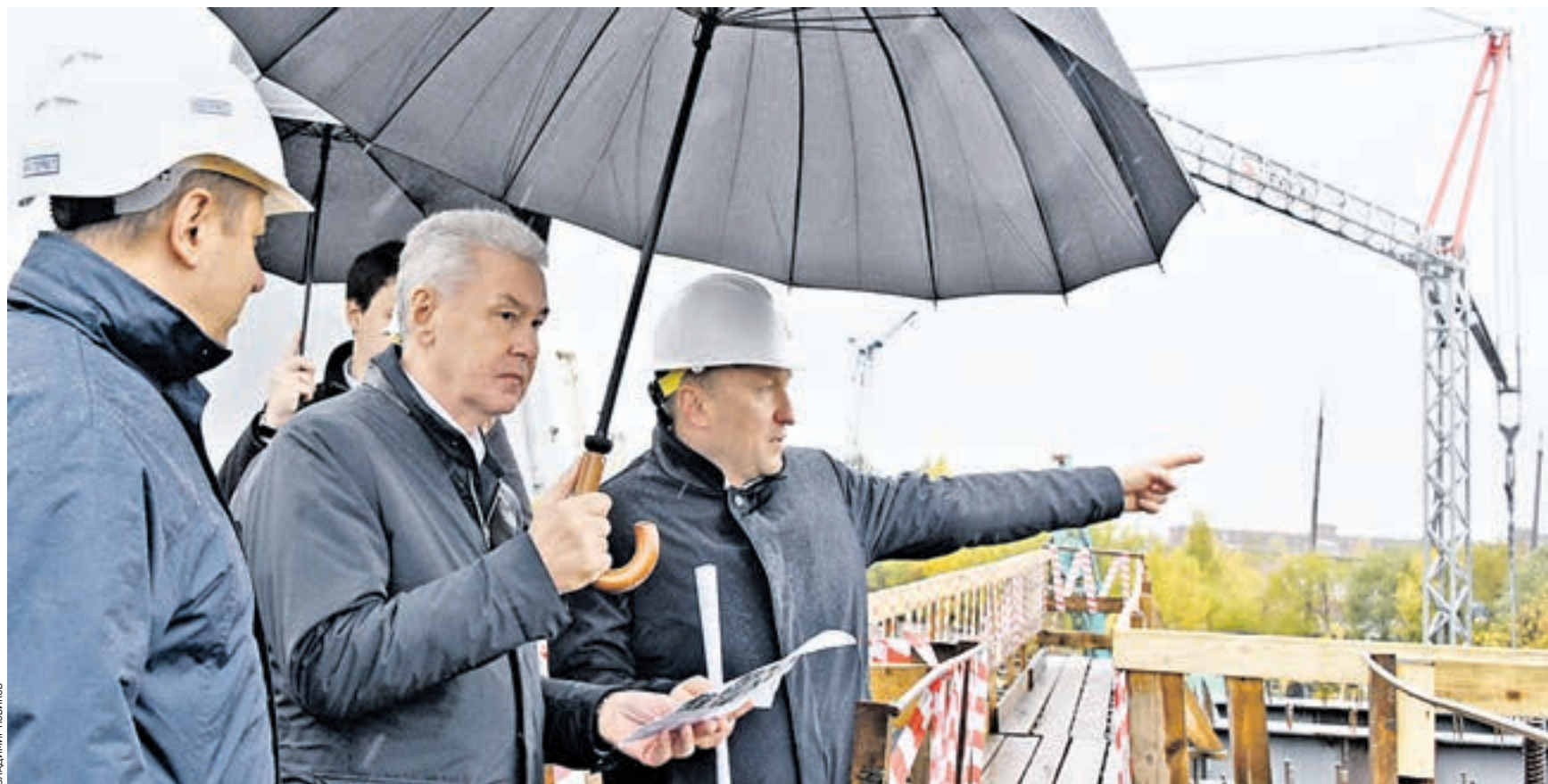
Вчера 11:10 Мэр Москвы Сергей Собянин (в центре) вместе с руководителем Департамента строительства Москвы Андреем Бочкаревым (справа) и генеральным директором компании-подрядчика Владимиром Власовым осматривают ход строительства южного участка Северо-Западной хорды
