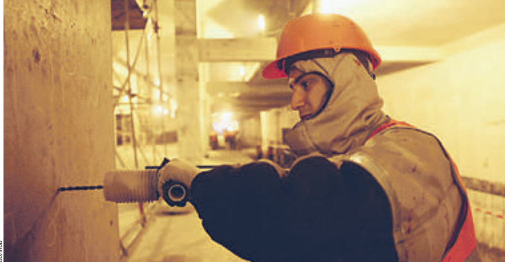
21 февраля 2016 года 12:06 Рабочий-метростровец Руслан Чернышов сверлит стену строящегося вестибюля станции метро «Петровский парк»
