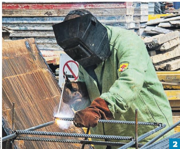
Проект станции метро «Улица Новаторов» (1) 4 августа 2020 года. Строительство станции «Университет Дружбы Народов» (2)
