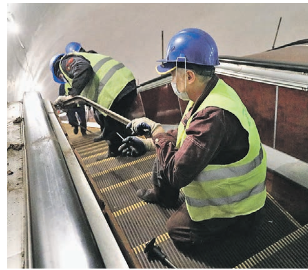
26 ноября 2020 года. Реставрация и замена эскалаторов вестибюля станции «Новослободская»
